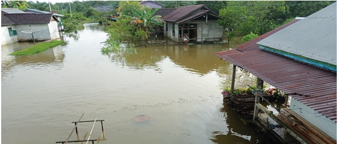
Gambar 17. Banjir Menggenangi Pemukiman Dusun Setontong-Desa Kualan Hilir (Sumber: Dokumentasi Masyarakat, 28 November 2024)
